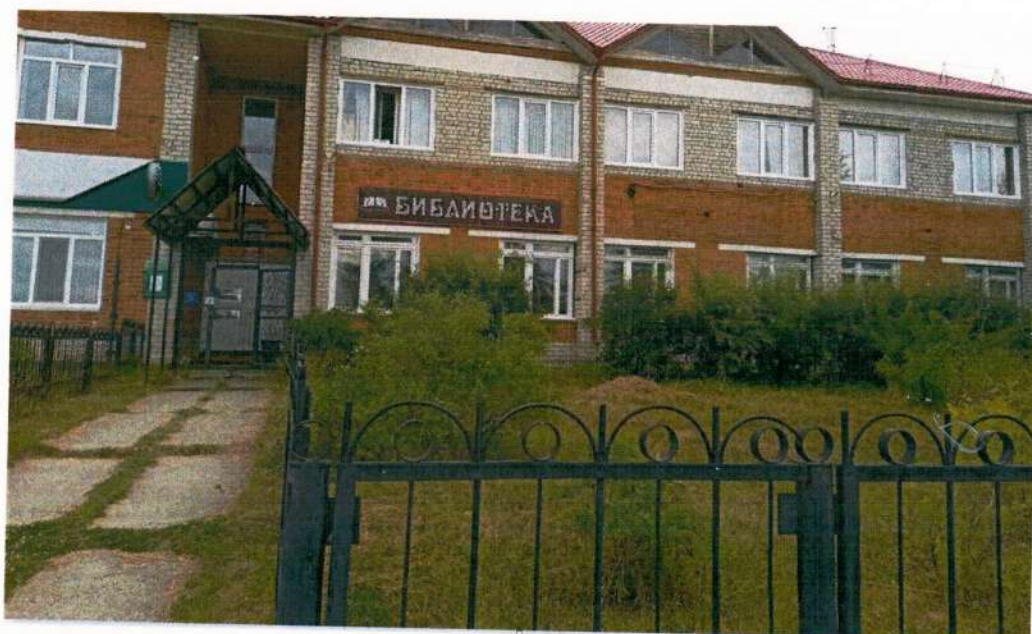
1. Территория, прилегающая к зданию (участок)
